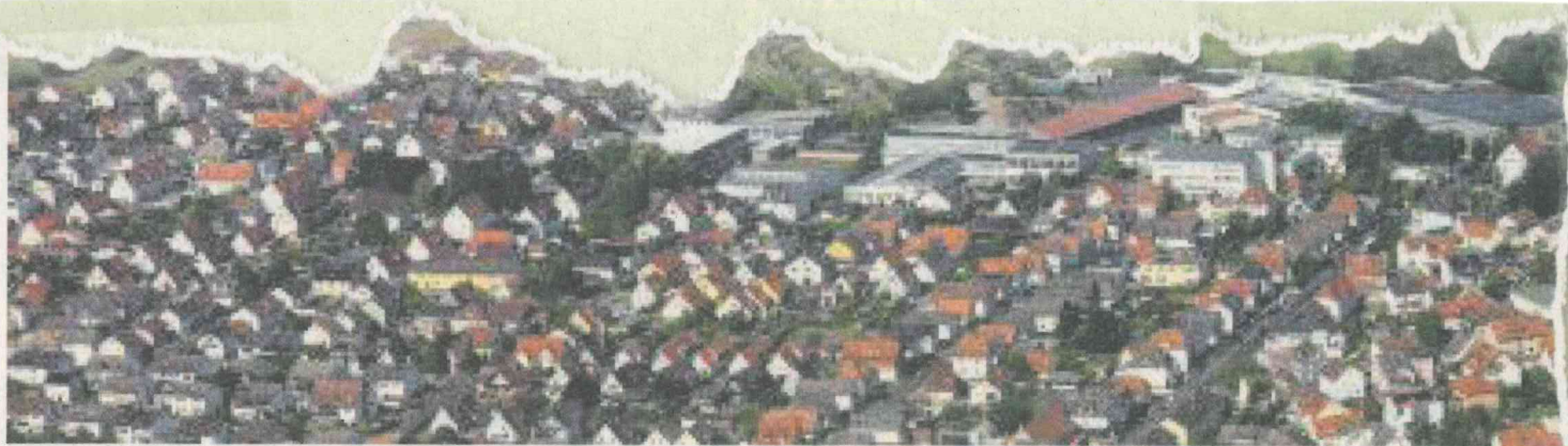
Das Wellpappe-Areal (Bildmitte) mit dem westlich (links) angrenzenden Energiepark, der zum Großteil auf Gelände entstanden ist, das zur Wellpappe gehört.
